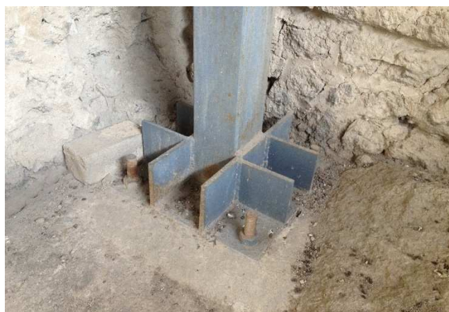
Fig. 29: Dettaglio del plinto di fondazione nel getto in cls.
