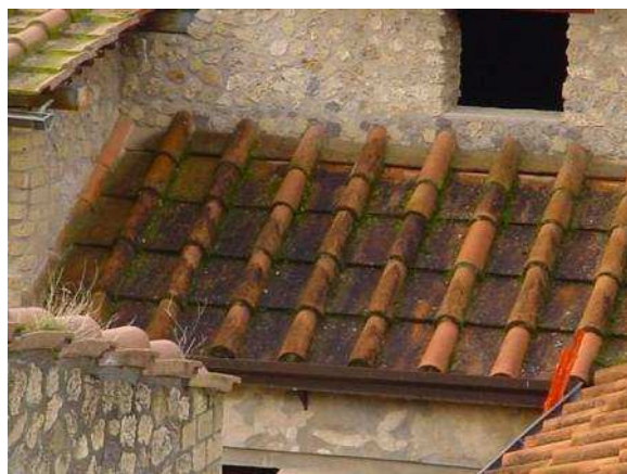
Fig. 24: Portico sud, manto laterizio bagnato ore dopo la pioggia.
