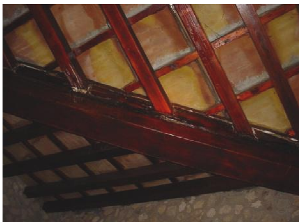
Fig. 23: Deposito, marcescenza della trave di compluvio.
