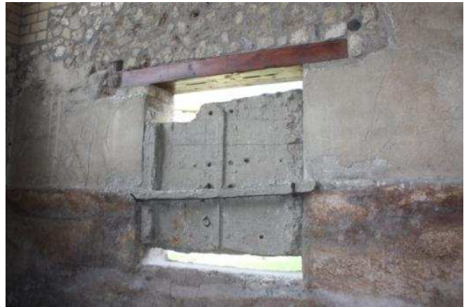
Fig. 39: Calcatorium, calco in cemento dei battenti della finestra.
