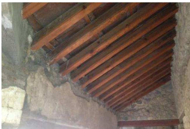
Fig. 17: Portico sud, orditura secondaria del tetto.
