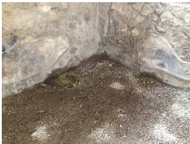
Fig. 28: Cubicolo Vbis, gocciolamento d'acqua sul lapillo e imbibizione del piede delle murature.
