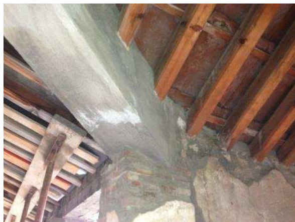
Fig. 18: Portico sud, trave di compluvio in cls armato.
