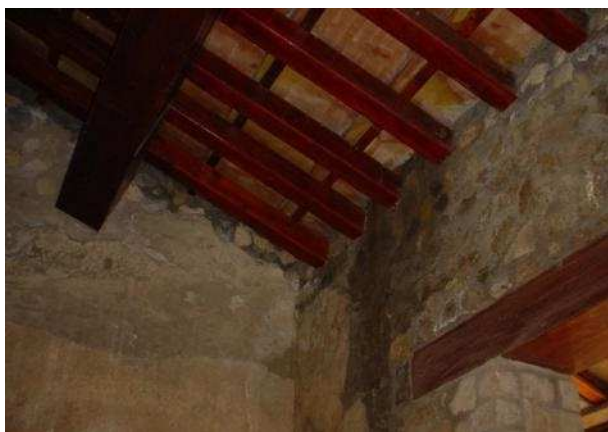
Fig. 21: copertura del Torcularium in legno lamellare.
