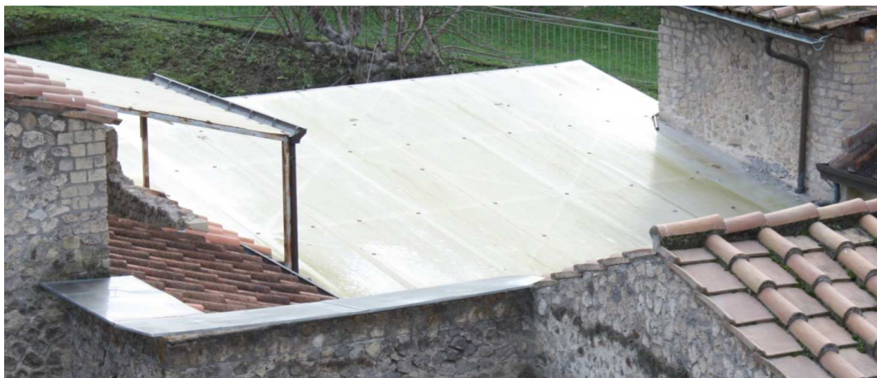
Fig. 30: Le due coperture a struttura metallica e lastre in polycarbonato: braccio nord del Portico (area VII) e Cella Vinaria.
