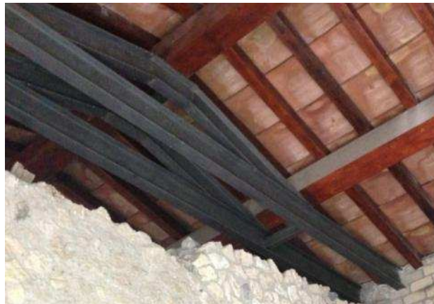
Fig. 22: copertura del Triclinio-Fienile con capriata in acciaio.
