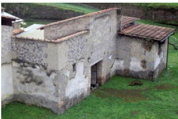
Fig. 7: Deposito, coperture eseguite a filo muratura.
